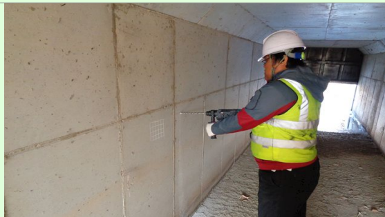
탄산화 깊이 측정
